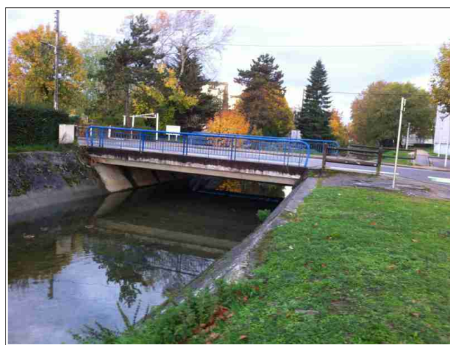
Pont de la rue des Dîmes, aval
