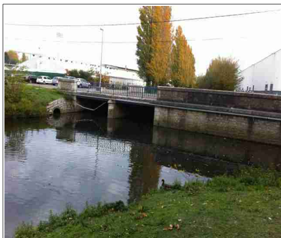
Pont de l'Allée de Challes / Stade-Verchère, amont
